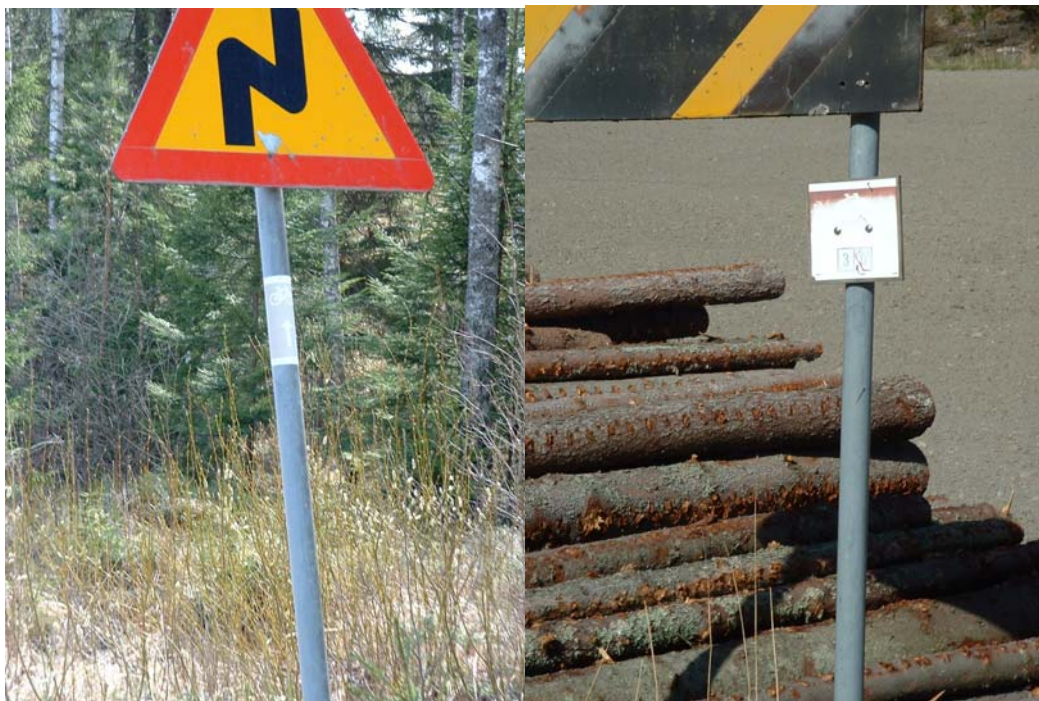
Kuva 3. Tarraopasteet ovat yleisesti ottaen huonossa kunnossa.
